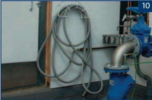
Задвижки и обратные клапаны вынесены в павильон для удобства обслуживания. Павильон имеет освещение, обогрев, раковины с кранами (по заказу), подъемный механизм (ручной или электрический), телескопическая балка (опционально).
